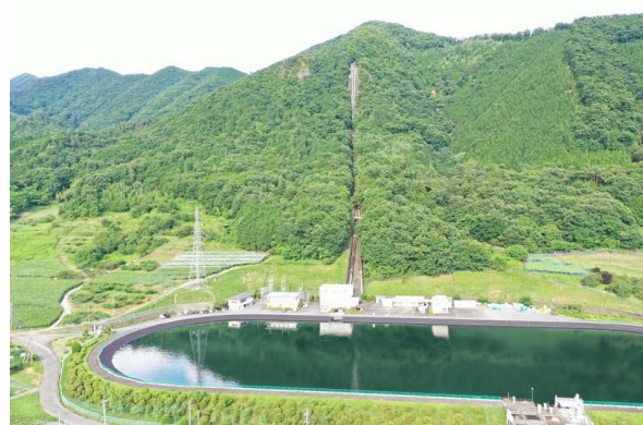
【山梨県営柚ノ木発電所】
